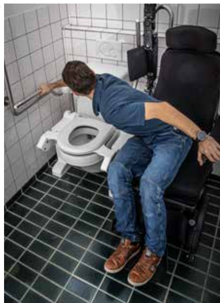
Photographie 6: Des WC accessibles en fauteuil roulant sont suffisamment spacieux et équipés de barres d'appui permettant à l'utilisateur un transfert autonome vers la cuvette.
