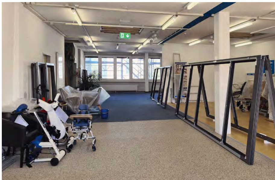
Bild 4: Im ganzen Gebäude wurden die Fenster ersetzt, um ein ökologischeres Umfeld zu schaffen.
