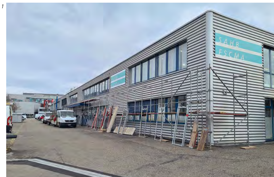
Bild 2: Das neue Stockwerk besteht aus ökologischem Baumaterial.
