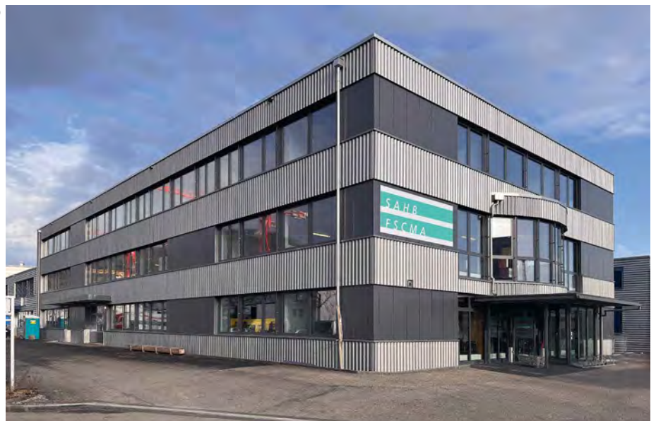
Bild 9: Das fertige, aufgestockte Gebäude mit der neuen Fassade.
