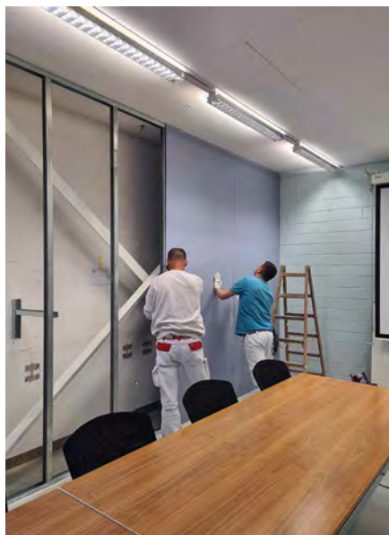
Bild 5: Die Arbeiter verbauten im Unter-, im Erd- und im ersten Obergeschoss Erdbebenpfeiler. Bild 6: Ein neuer Stock entsteht – der Holzbau in der Rohbauphase.
