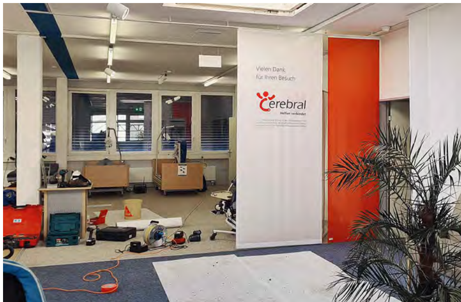
Bild 3: Die Exma VISION während der Umbauphase
