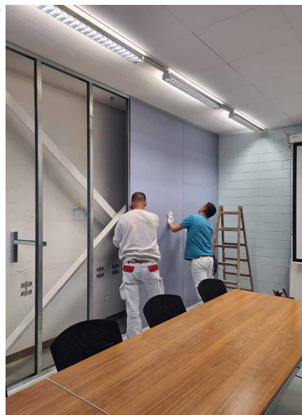
Photographie 5 : Les ouvriers installent des piliers sismiques au sous-sol, au rez-de-chaussée et au premier étage.
