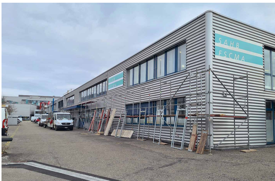
Photographie 2 : Le nouvel étage est réalisé en matériaux écologiques.
