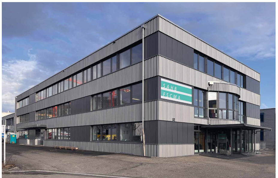
Photographie 9 : Le bâtiment achevé avec l'étage 9 supplémentaire et la nouvelle façade.
